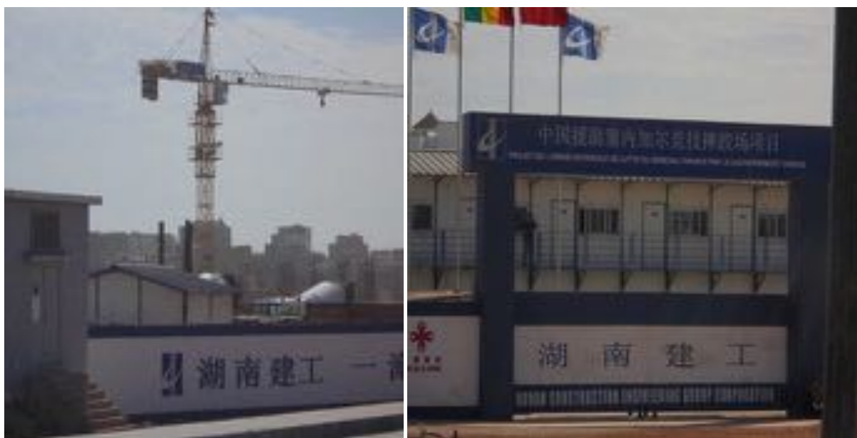
Chantier de l'Arène nationale sur une emprise de 8 ha dans une zone agricole (Technopole).
